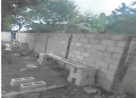
Foto 1: Remozamiento muro perimetral de block
