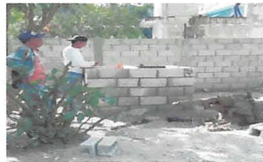
Foto 4: Sustitucion de pila por pila concreto de un lavadero capacidad de 5 toneles aproximadamente
