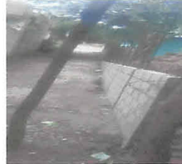
Foto 2: Remozamiento muro perimetral de block
