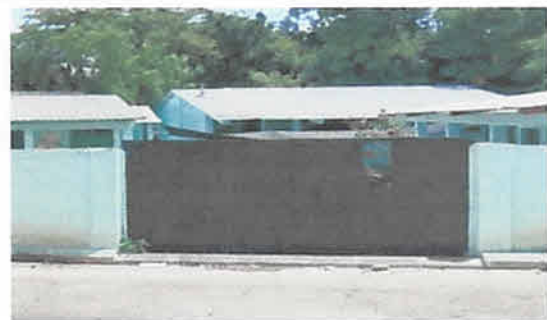
Foto 6: Mantenimiento de porton lijado y soldadura
